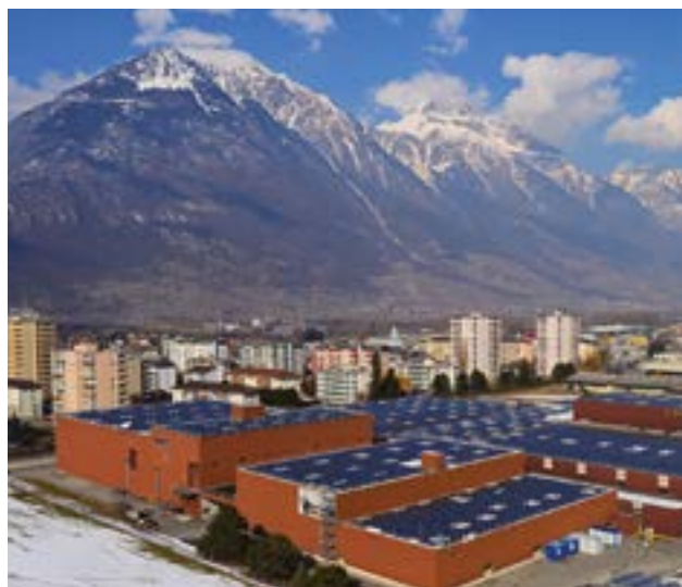
La centrale photovoltaïque installée sur les toits des caves Orsat produit 1,5 million de kWh par an.
