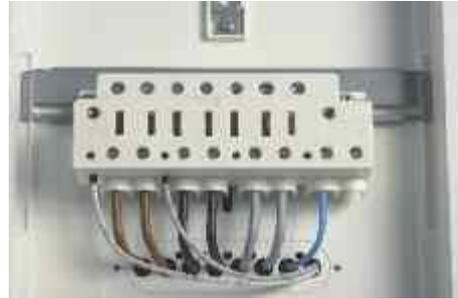
Développé par la maison Hager, ce système permet de remplacer rapidement et en toute sécurité des compteurs sans interrompre l'exploitation des installations en aval.
